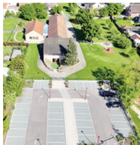
Aménagement du parking de l'école Paul Klee
